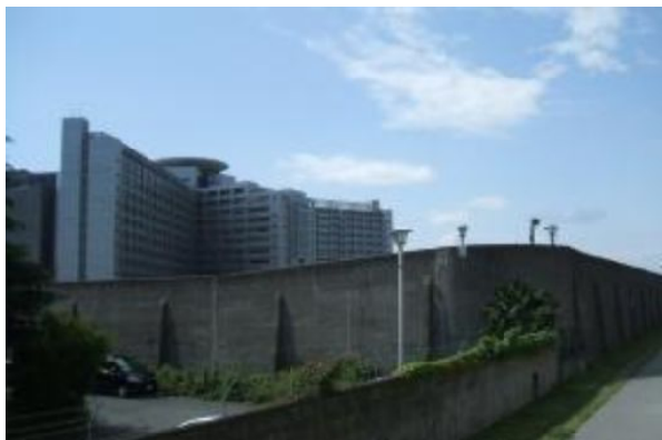
小菅にある東京拘置所の外観
